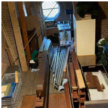
De gerestaureerde en nieuwe orgelpijpen liggen klaar voor plaatsing.
