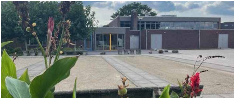
aanbouw tuinkamer (met geel in het kozijn) en aanbouw sportzaal buitenzijde
